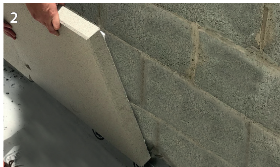
Прикрепите плитку к основанию, сильно надавив на нее
