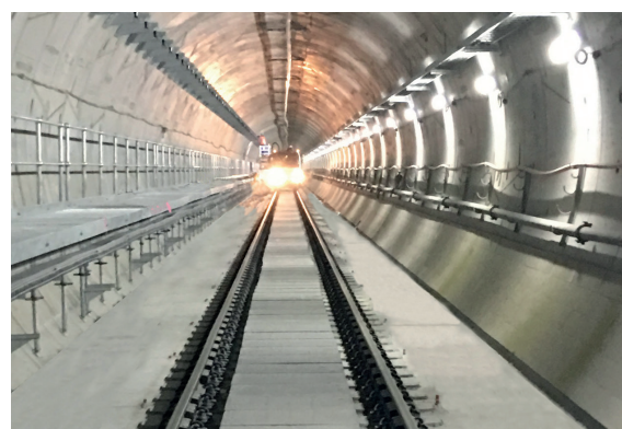
Применение в туннелях - Панели Rearor устанавливаются на стену
